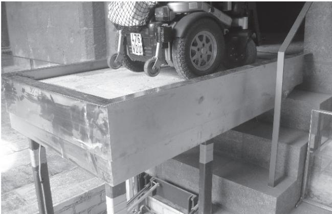
Im Kreuzgang wurde eine denkmalgerechte Hubbühne installiert, über die man mit dem Rollstuhl in alle Seitenräume gelangt. Am Eröffnungstag hatte man allerdings im Kreuzgang Trennwände aus Glas aufgestellt, um den Besucherstrom zu kanalisieren. Diese erschwerten nicht nur das Manövrieren mit dem Rollstuhl sondern sie verhinderten den Zugang zum Aufzug, so dass dieser nicht benutzt werden konnte. Auf den Hinweis des Landesbehindertenbeauftragten hin, wurden die Glaselemente wieder abgebaut.
